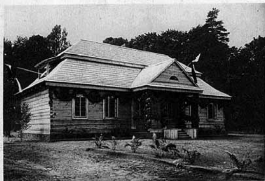
349. Schronisko P. T. K. nad Switezia.
