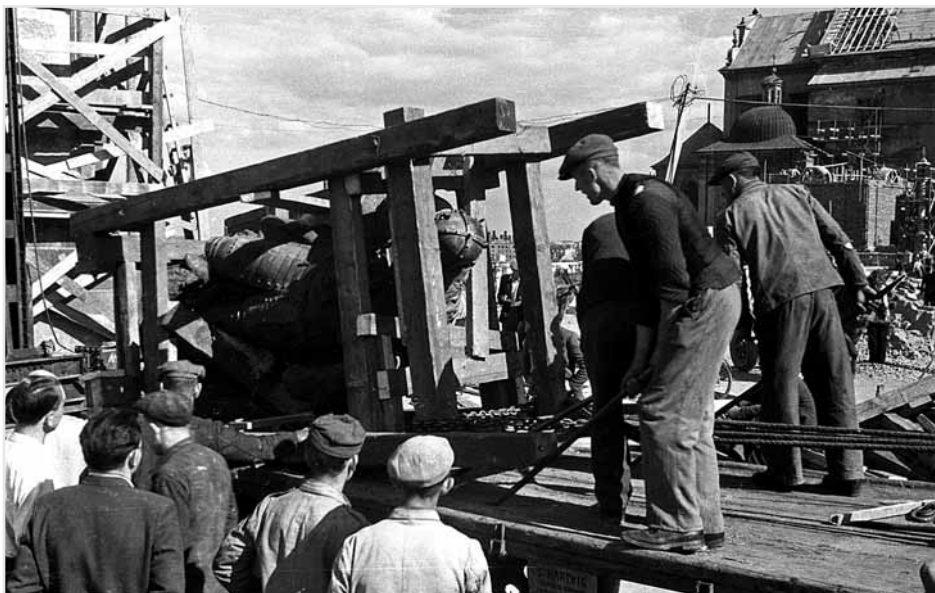
Odbudowa Warszawy ze zniszczeń dokonanych w czasie II wojny światowej, lata czterdzieste XX w. Fot. E. Falkowski. Ze zbiorów Centrum Fotografii Krajoznawczej PTTK w Łodzi
