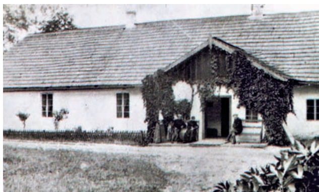
Fot. 7. Dwór w Głanowie przed przebudową, widok od południa. Początek lat 20-tych XX w.
