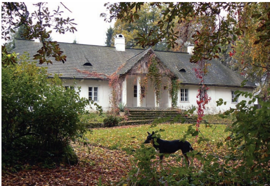
Fot. 10. Dwór w Tarnawie widok od frontu, stan obecny
