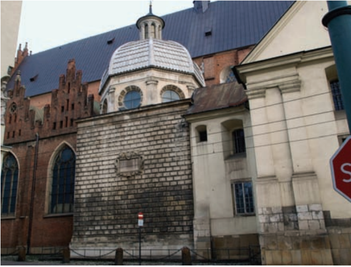
Ryc. 4. Południowa fasada kościoła św. Trójcy w Krakowie: w części centralnej zbudowana z wapienia pińczowskiego kaplica Myszkowskich z charakterystyczną kamienną kopułą, po prawej kaplica Matki Bożej Różańcowej (fot. M. Szuwarzyński)
