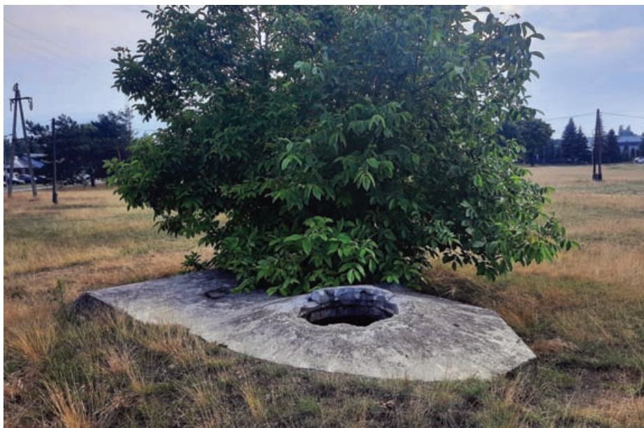
Fot. 3. Lekki schron bojowy typu Ringstand 58c, Tomaszów Mazowiecki, ul. Nowy Port (fot. M. Reczycki)
