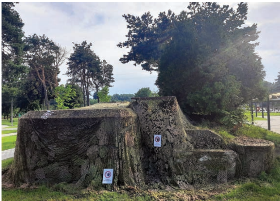
Fot. 4. Ciężki schron bojowy typu Ringstand 58c (Bauform 201), Tomaszów Mazowiecki, ul. PCK (fot. M. Reczycki)
