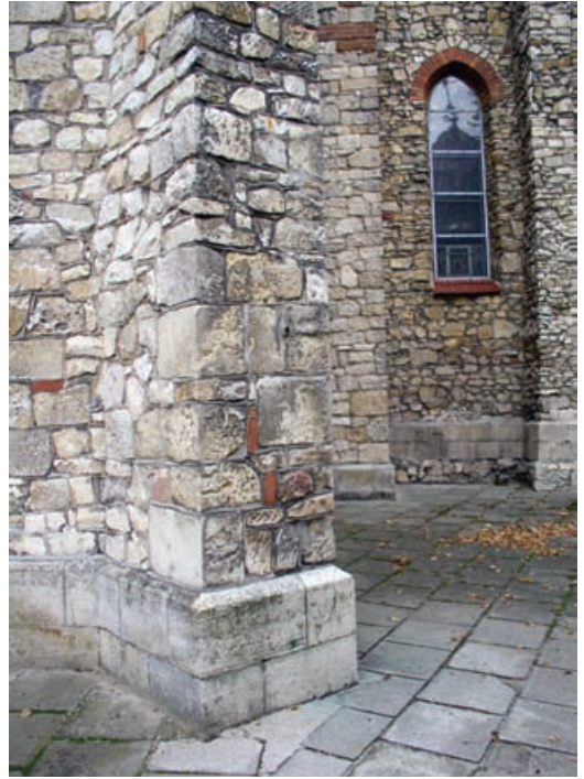
Ryc. 2. Fragment południowej ściany kościoła św. Mikołaja w Chrzanowie zbudowanej z dzikiego kamienia dolomitowego, z użyciem ciosów dolomitowych (okładzina cokołu budowli i wzmocnienia naroży) (fot. M. Szuwarzyński)
