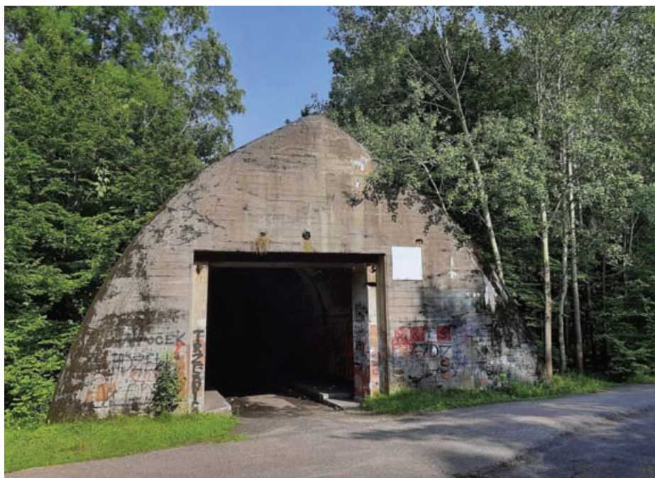
Fot. 9. Schron stanowiska dowodzenia „Anlage Mitte” w Jeleniu (fot. M. Reczycki)
