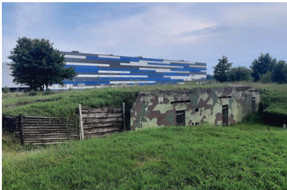
Fot. 1. Schron bierny piechoty typu Regelbau 621, Tomaszów Mazowiecki, ul. Strzelecka (fot. M. Reczycki)
