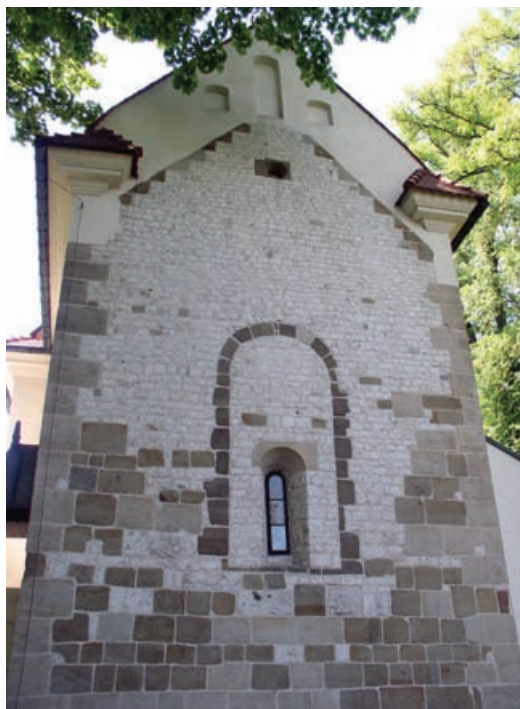
Ryc. 1. Struktura muru kamiennego w zamknięciu prezbiterium kościoła Najświętszego Salwatora w Krakowie: elementy wykonane z wapienia – białe, z piaskowca – w różnych odcieniach szarości (fot. M. Szuwarzyński)
