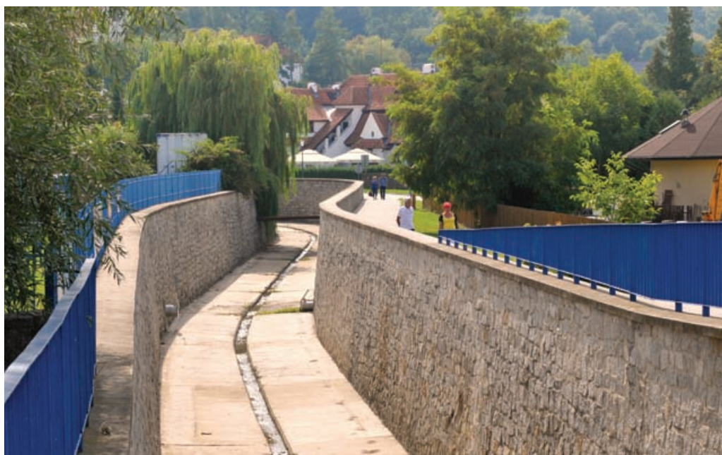
Ryc. 24. Wymurowane koryto cieką Grodarz w unikatowym kulturowo miasteczku Kazimierz Dolny (fot. Sz. Chmielewski)
