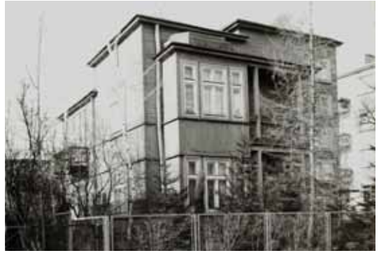
Fot. 12. Willa przy ul. Grottgera 6 na pocz. lat 90. XX w. (fot. ze zbiorów Wojewódzkiego Urzędu Ochrony Zabytków w Białymstoku)
