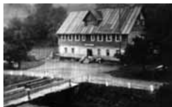
Fot. 4. Nawiązująca do regionalnych wzorców architektonicznych forma schroniska „Saalwiesenbaude” (wieś Bielice; początek XX w). Źródło: http://www.bielice.info/pl/
