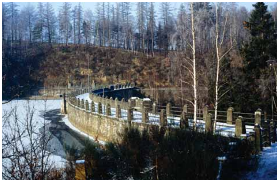
Fot. 1. Zapora na Kwisie w Złotnikach Lubańskich
