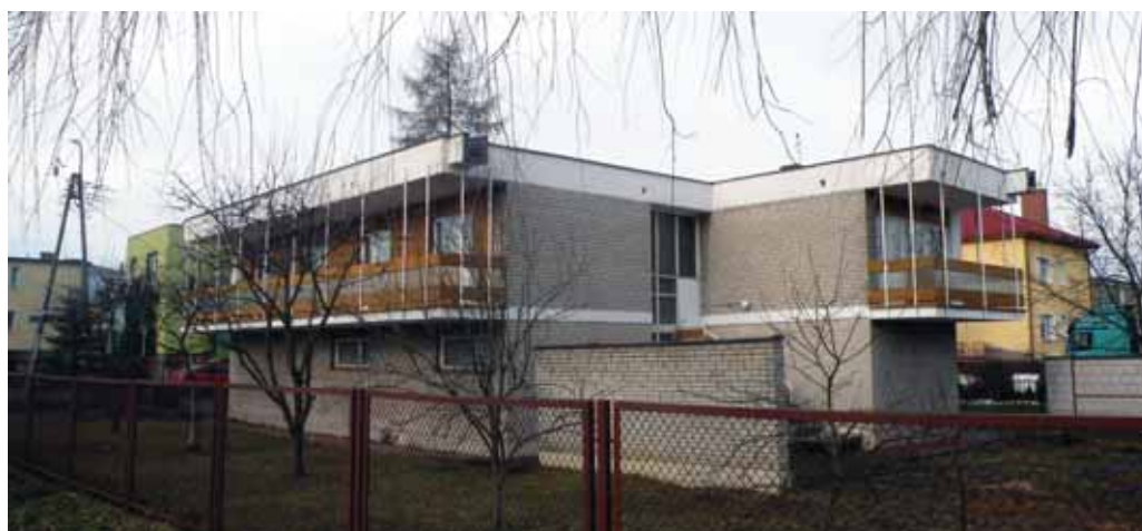
Fot. 14. Dom przy ulicy Zajęcej 29, luty 2009 (fot. S. Wicher)
