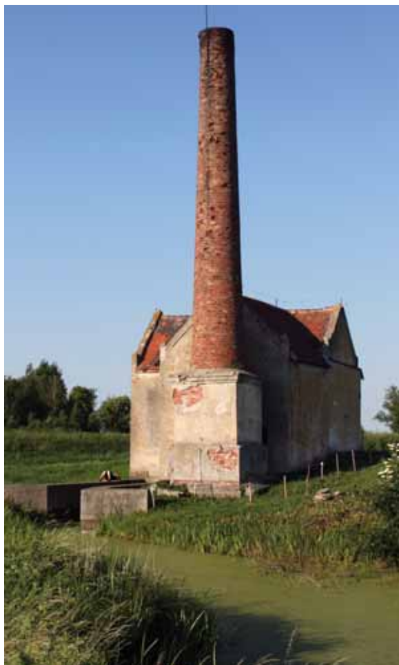
Fot. 12. Przepompownia parowa w Różanach (fot. Leszek Marcinkowski)
