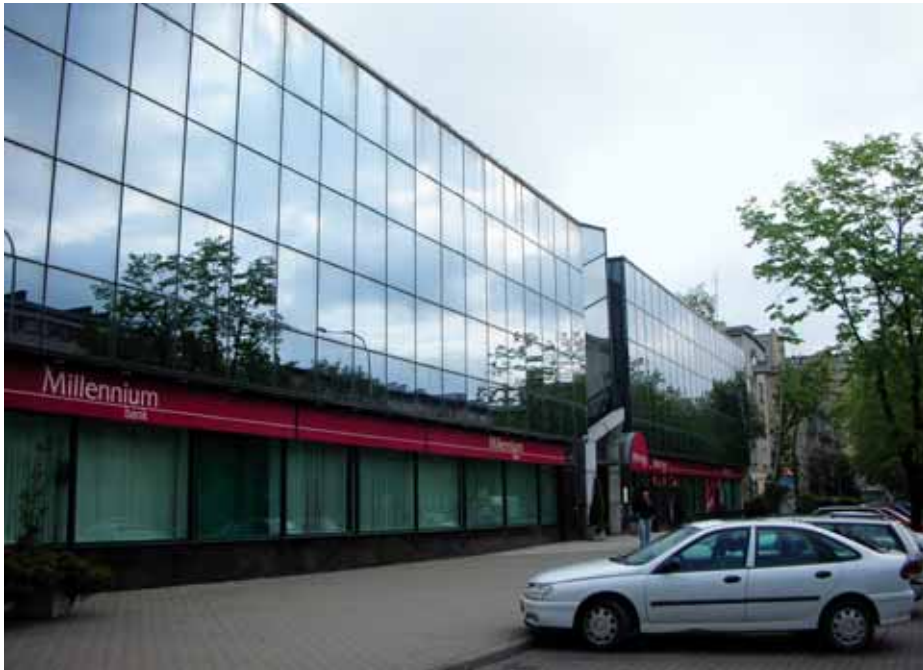
Fot. 7. Dawny pawilon handlowy „Eldom” po przebudowie na potrzeby banku, stan z maja 2007 r. (fot. S. Wicher)
