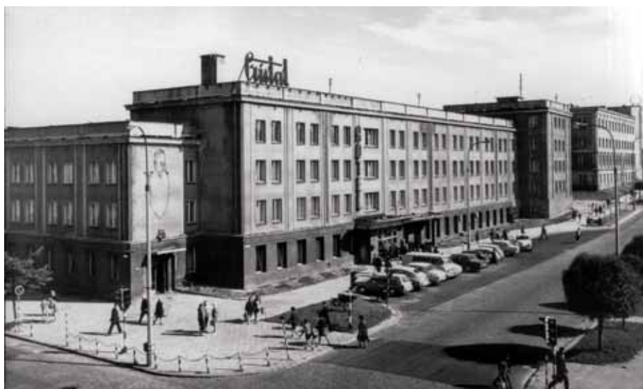
Fot. 8. Hotel „Cristal” przy ulicy Lipowej 3/5, 1970 r. (fot. M. Gadzalski, ze zbiorów J. Łempickiej)
