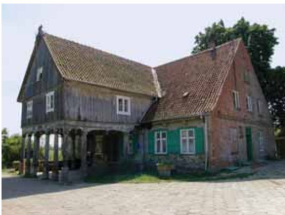
Fot. 7. Dom podcieniowy z 1810 r. w Kępniewie
