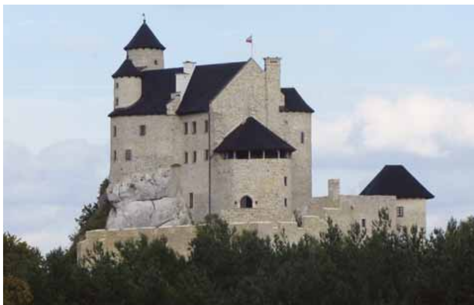
Ryc. 13. Odbudowany zamek w Bobolicach (fot. D. Ziarkowski)
