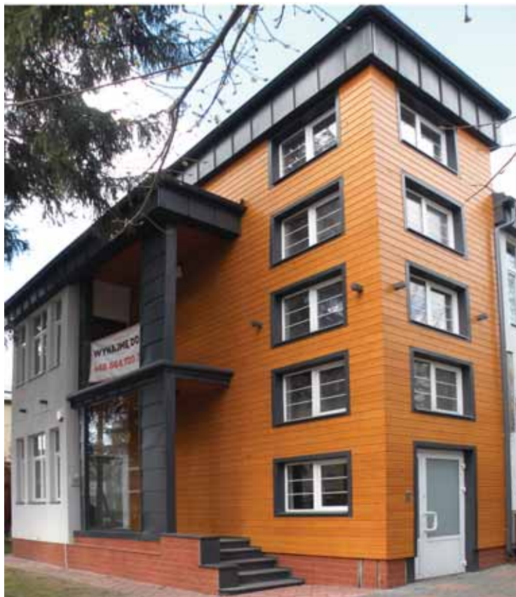
Fot. 13. Willa przy ul. Grottgera 6 po przebudowie, kwiecień 2015 (fot. S. Wicher)
