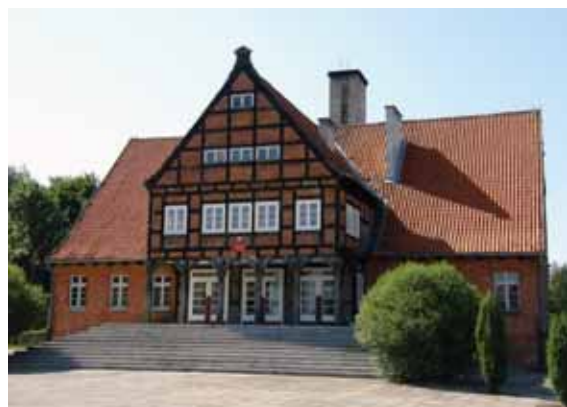
Fot. 9. Budynek szkoły w Zwierznie
