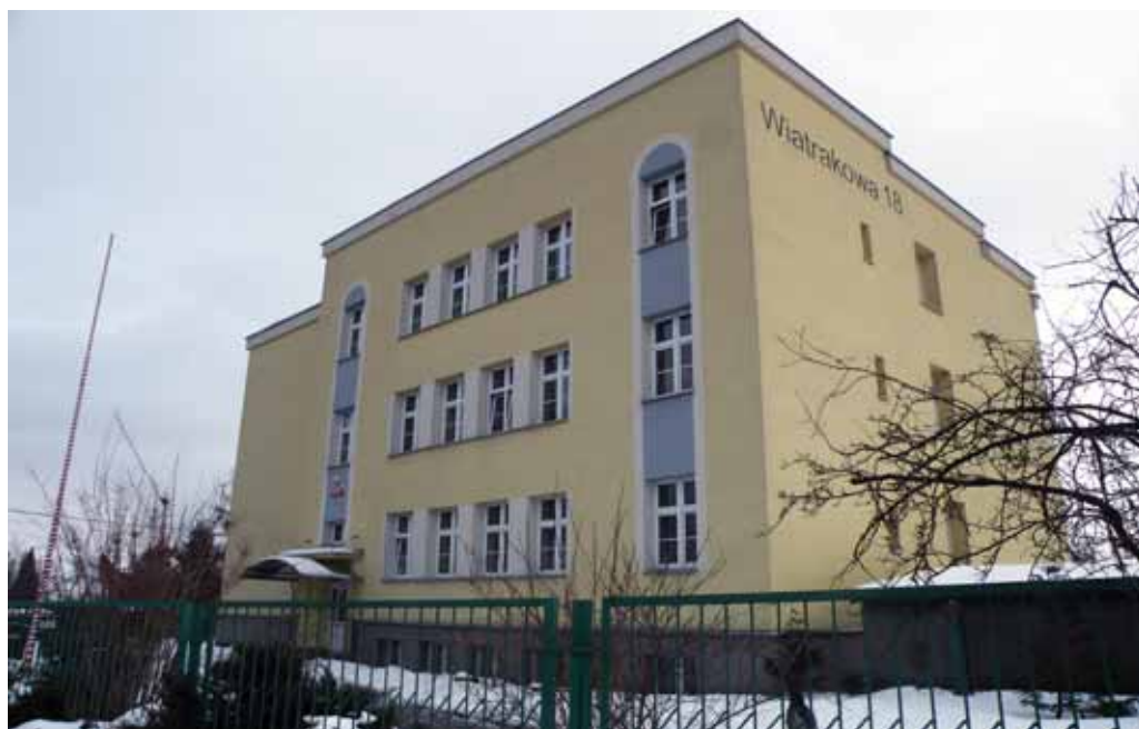
Fot. 11. Szkoła Podstawowa nr 7 im. Hugona Kołłątaja po pracach termomodernizacyjnych, luty 2012 (fot. S. Wicher)
