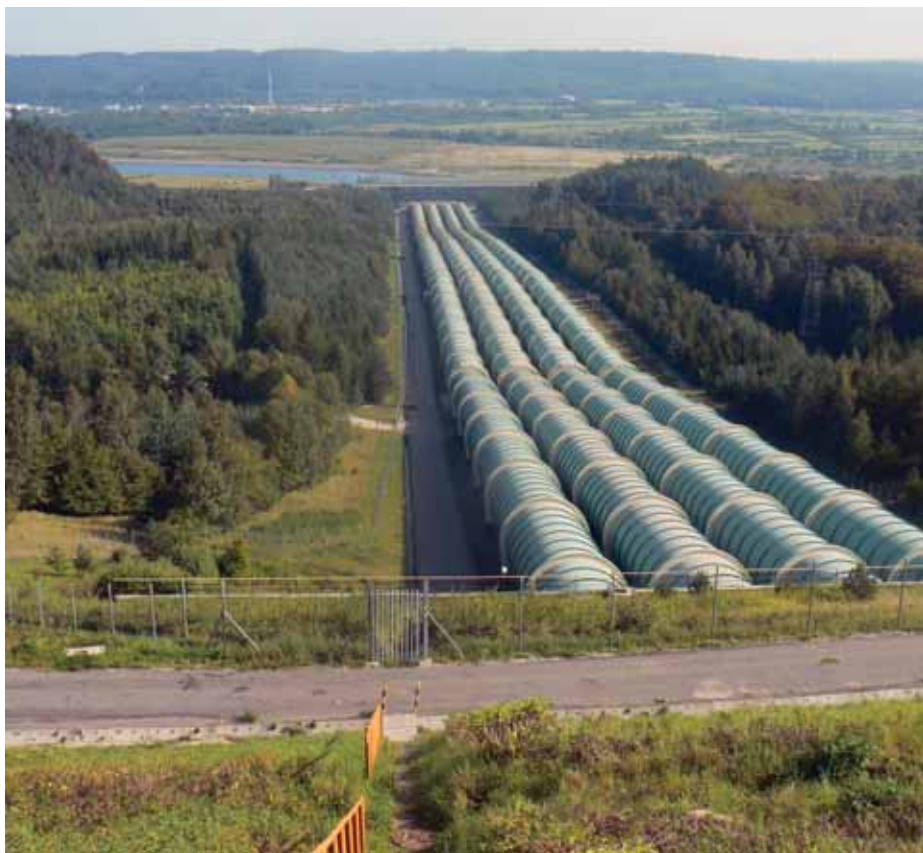
Fot. 3. Żarnowiec. Rury elektrowni wodno-szczytowej w krajobrazie pomorskim
