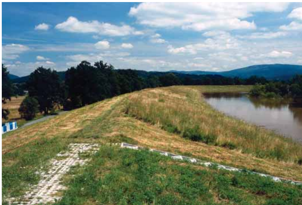
Fot. 7. Zbiornik w Mysłakowicach napełniony wodą powodziową, w tle Rudawy Janowickie
