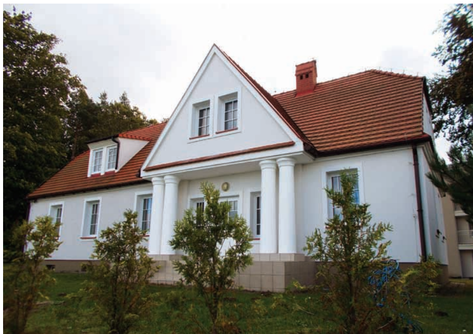
Fot. 21. Willa Mewa – elewacja północna. Fot. Tomasz Rzewuski
