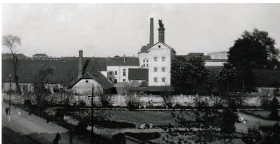
Ryc. 11. Browar w 1940, widok od Plant Kolejowych. Archiwum MWKZ
