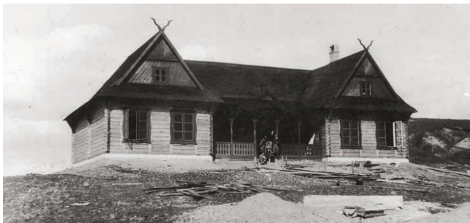
Ryc. 12a. Schronisko PTK im. K. Kulwiecia w Starym Folwarku w końcowym etapie budowy, 1929. Fot. Narodowe Archiwum Cyfrowe
