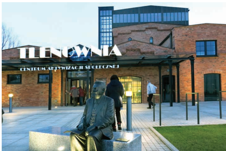
Fot. 13. „Tlenownia”, dawna wytwórnia tlenu przebudowana w 2022 r. na obiekt kulturalno-społeczny w Czempiniu (pow. kościański, wycieczka 52, 2023 r.). Fot. Zbigniew Szmidt
