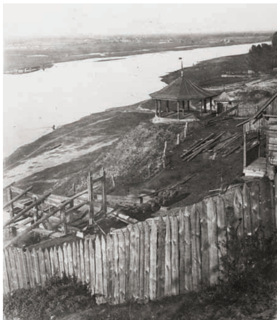
Fot. 8. Nowogród, budowa skansenu, 1925 r. Fot. CFK PTTK
