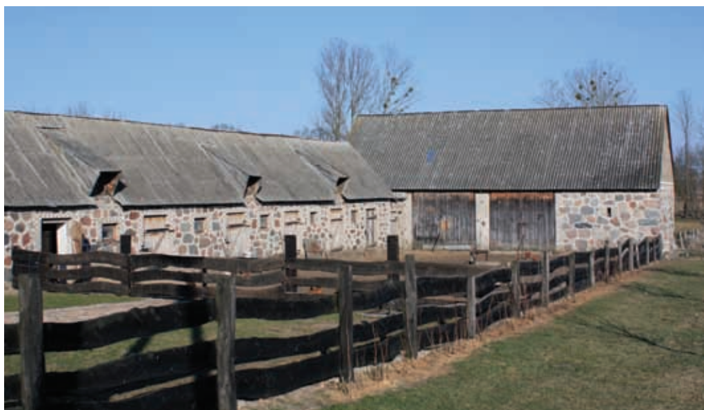
Il. 8. W budownictwie gospodarczym w Dolinie Biebrzy często wykorzystywane są głązy narzutowe (fot. Joanna Plit)
