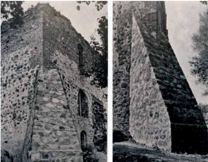
Il. 8. Troki. Ruiny zamku na wyspie. Plan rekonstrukcji szkarp z 1929 i zrekonstruowane szkarpy. Repr. wg S. Lorentz, Konserwacja ruin... , op. cit., ryc. 36–37.
