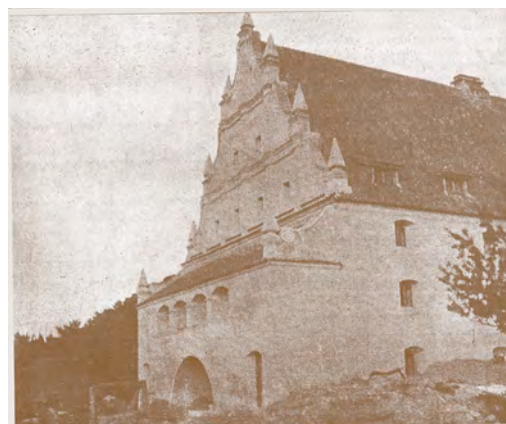
Stary śpiczlerz w Kazimierzu nad Wisłą, wyremontowany w ramach planu inwestycyjnego. Wnętrze adaptowane na nowoczesne schronisko turystyczne PTK. Fot. W. Bağiński
